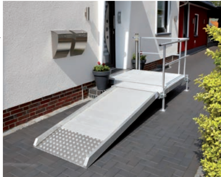
Der nachträgliche Anbau einer Rampe mit Radabweisern führt zur Haustür.
