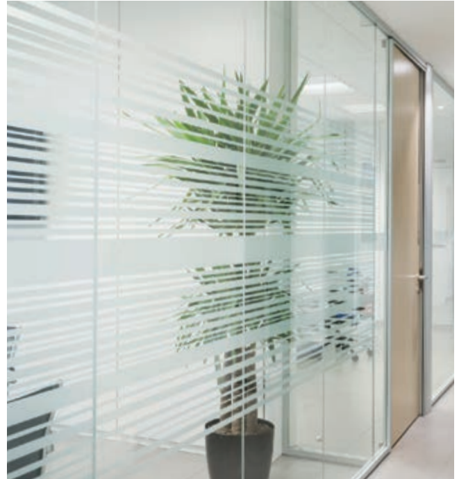
Die Glasfläche ist mit kontrastreichen Markierungen versehen.
