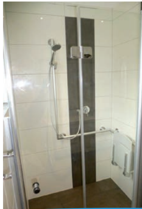
Bodengleiche Dusche mit fest installiertem Duschsitz.
